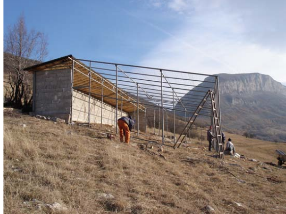
Volijera lake konstrukcije u Bugarskoj na Staroj planini, Vraca udaljena 42 km od Rsovca.
